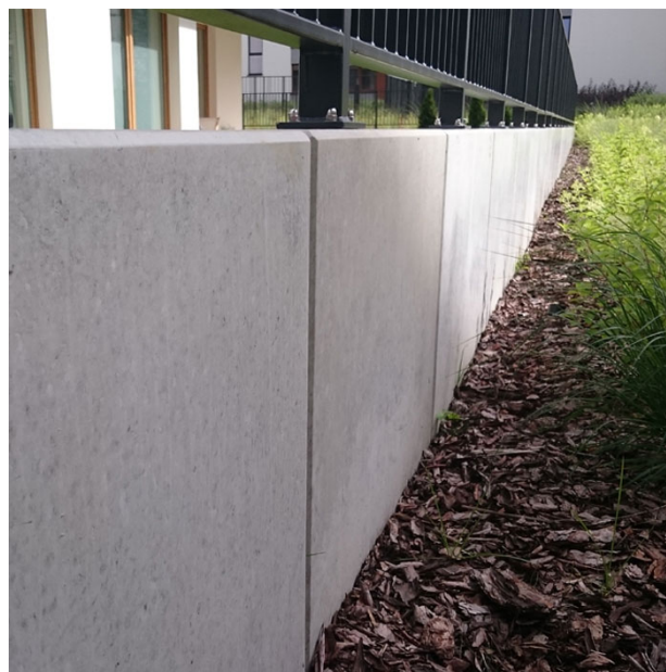
Mur oporowy z prefabrykatów L-kształtnych
